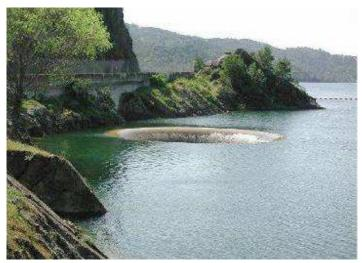
L'entonnoir du barrage de Monticello, en Californie. Il engloutit quelque 5000 mètres cube à la seconde. Sa fonction est d'évacuer l'excès d'eau du barrage.
