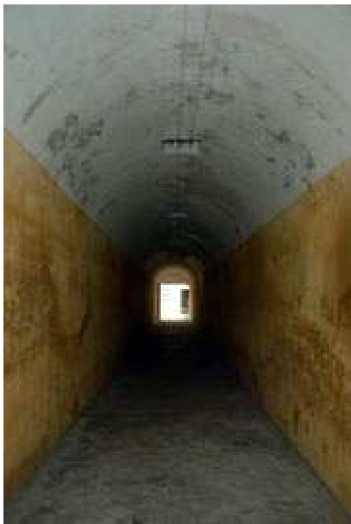
Đường hầm trong trại giam
